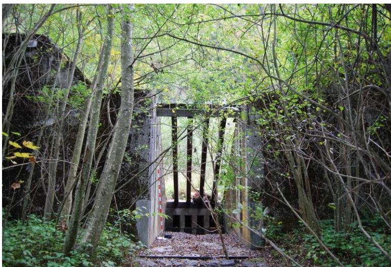
Foto Nr. 13: Abschlussbauwerk des Geschiebesammlers bei der Dollrunse Der Sammler hat eine Rückhaltekapazität von rund 3'500 m 3 . Das Abschlussbauwerk ist mit einem Rechen aus H- Trägern versehen (Vertikal- rechen). Ein Teil des Geschiebes kann während eines Ereignisses durch das Rechenbauwerk aus- getragen werden.
