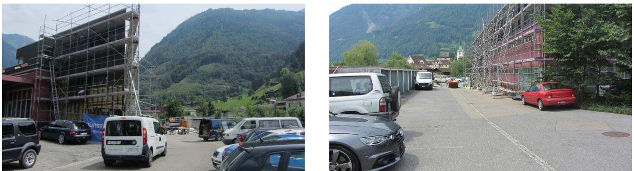
Abbildung 21: Sperrung der Route durch Baustelle (Schwanden)
