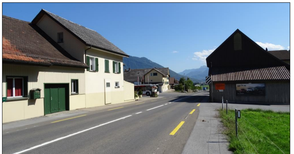
Fehlender Gehweg im Bereich Ussbühl
