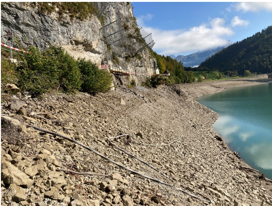
Foto 3: Talseitige Böschung Pm 0 – 115, grösstenteils aus Blockschutt bestehend, rund 30° bis lokal 35° steil.
