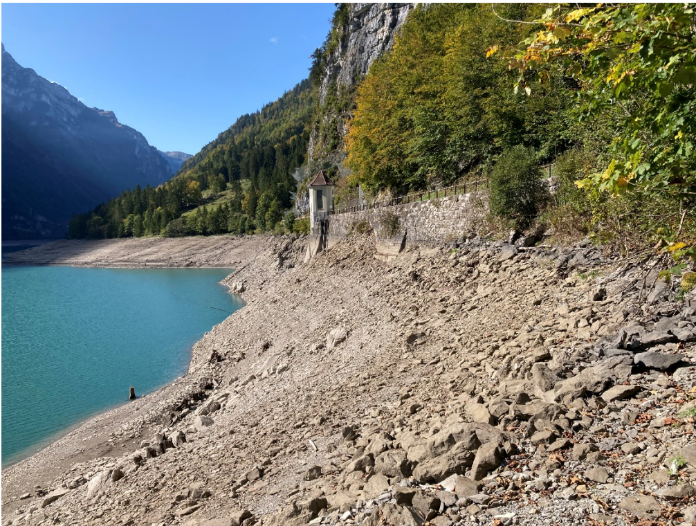
Foto 9: Talseitige Böschung Pm 315 – 215, grösstenteils aus Blockschutt bestehend, rund 20° bis 30° steil.
