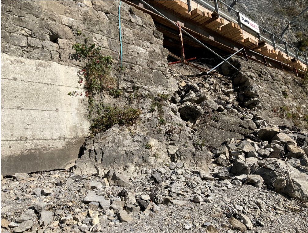
Foto 4: kleiner Felsaufschluss sowie angrenzende Betonunterfangung westlich der gut erkennbaren kollabierten Stützmauer..
