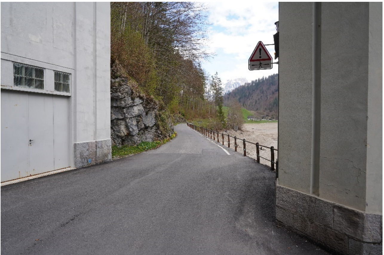
Abb. 8 Strasse im Bereich Ruestelchopf
