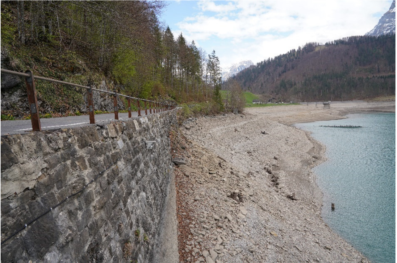
Abb. 10 Stützmauer im Bereich Vorder Ruestelchopf Seite Glarus
