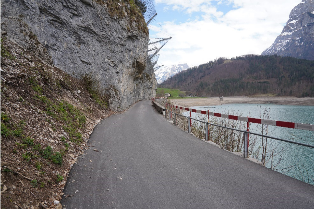
Abb. 5 Strasse im Bereich Vorder Ruestelchopf
