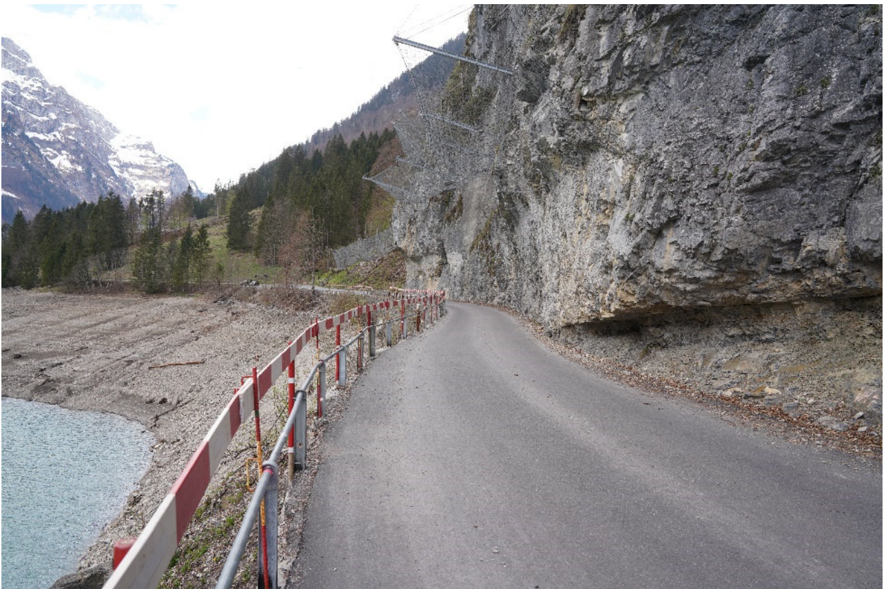
Abb. 6 Strasse im Bereich Vorder Ruestelchopf
