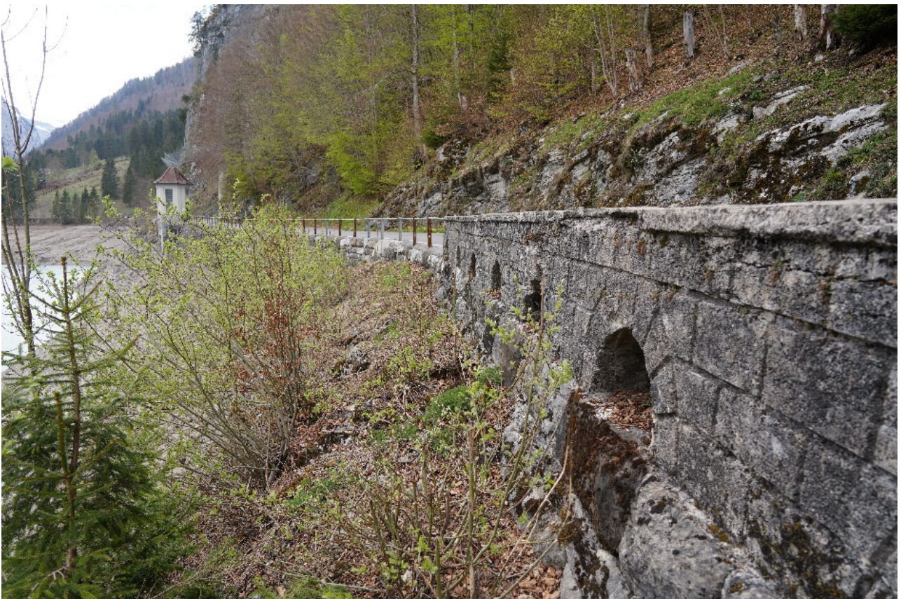
Abb. 11 Stützmauer mit Brüstung aus Beton im Bereich Vorder Ruestelchopf Seite Glarus
