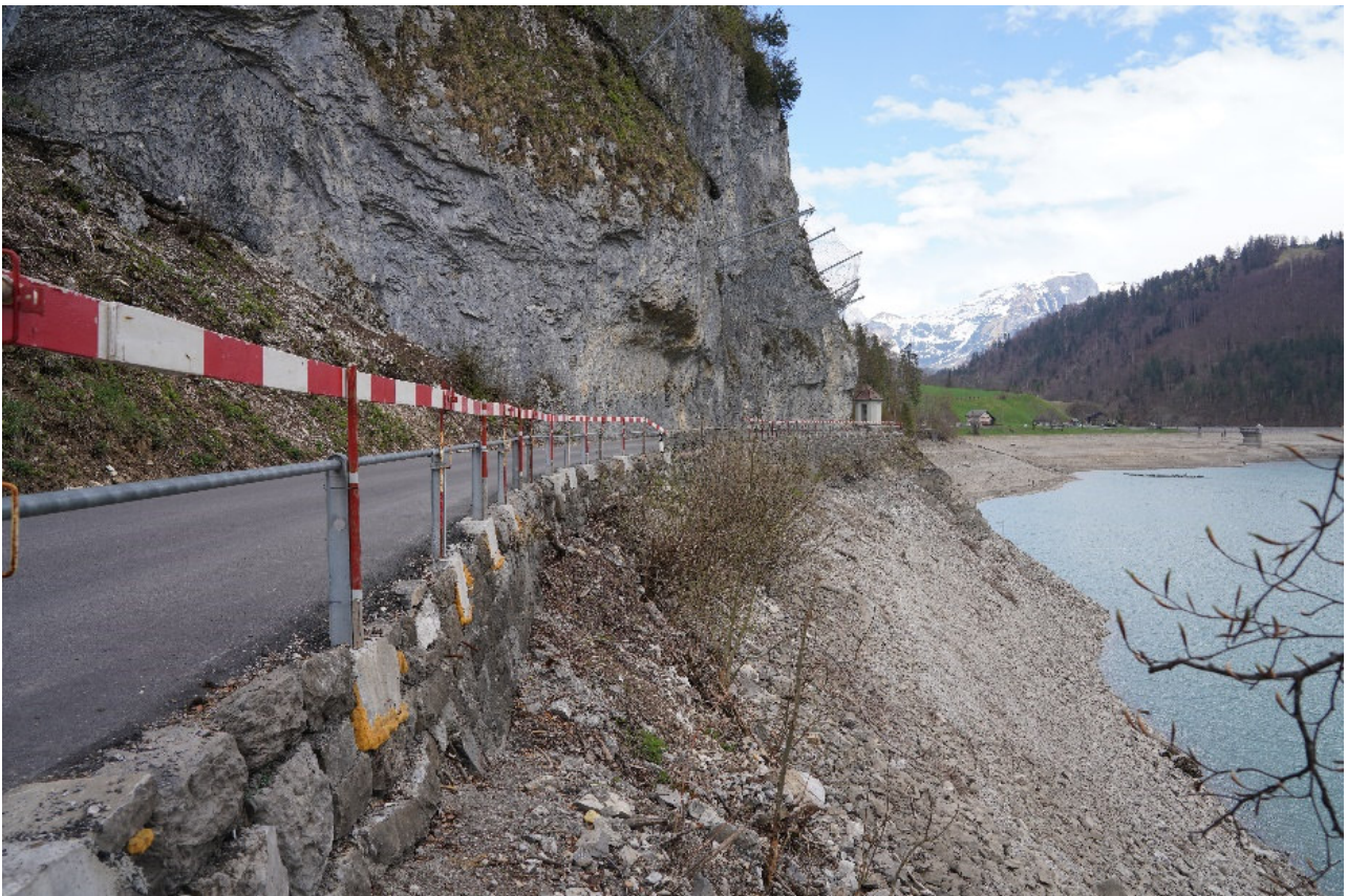
Abb. 9 Stützmauer im Bereich Vorder Ruestelchopf Seite Hinter Klöntal
