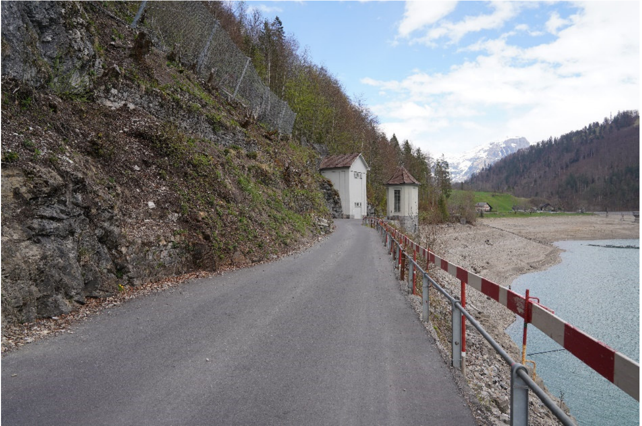
Abb. 7 Strasse im Bereich Vorder Ruestelchopf
