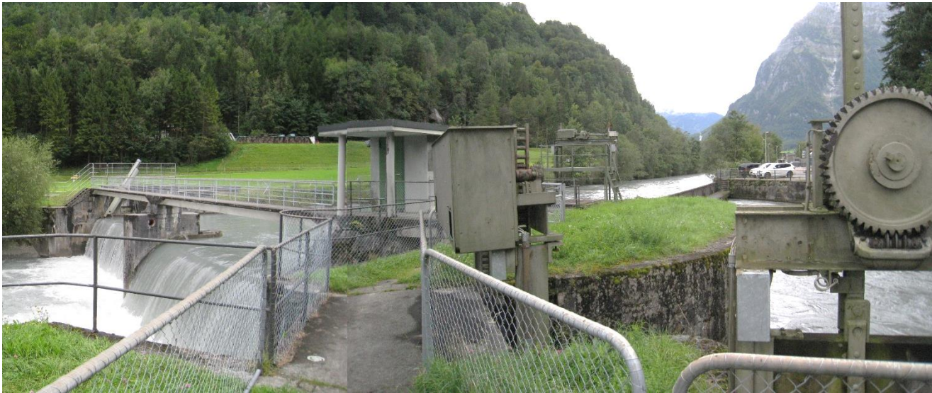
Abbildung 9-15: Linth mit Wehr und rechts davon der Kraftwerkkanal Papierfabrik
