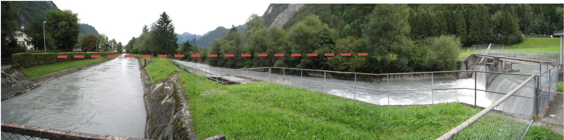
Abbildung 9-14: Kraftwerkkanal und Linth unterhalb des Wehrs, Blickrichtung: Nord
