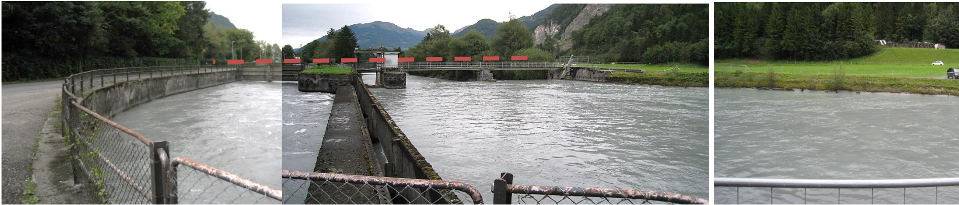
Abbildung 9-13: Abzweigung Kraftwerkkanal oberhalb des Linthwehrs
