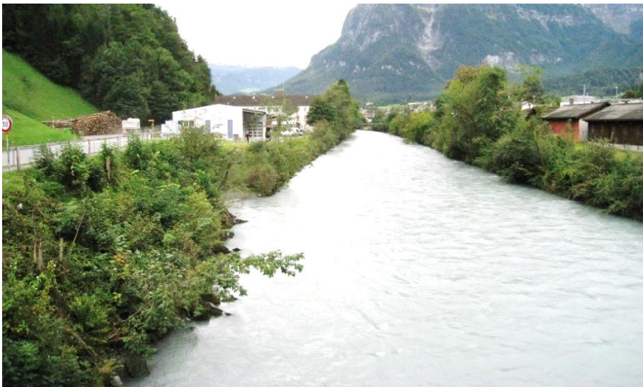
Abbildung 9-11: Standort bestehende Linthbrücke“, Blick nach Süden ...
