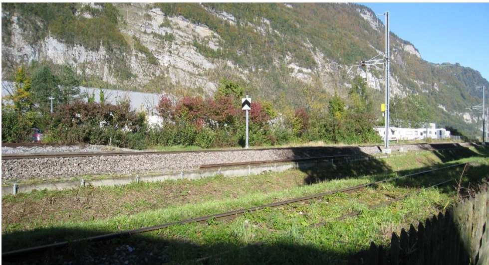
Abbildung 9-9: Stammgleis SBB und Industriegleis zur ACO
