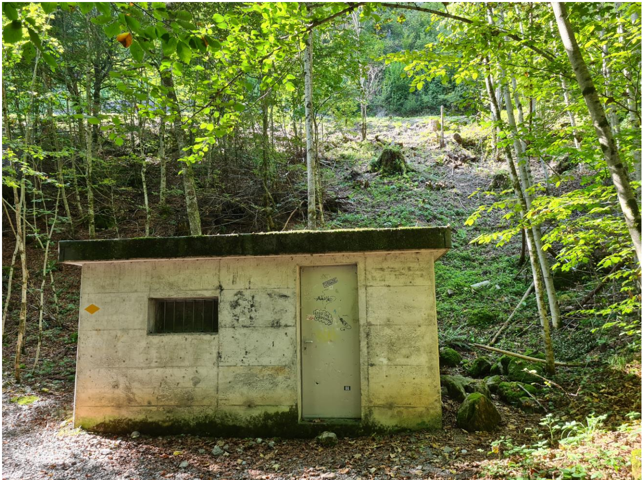
Abb. 11: Schiebergebäude Das betonierte Schiebergebäude wird zurückgebaut. (Foto: M. Ammann, 15.09.2020)
